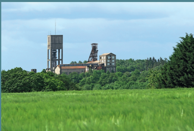
Noisseau, carreau minier de Bois 2, Conservation départementale du patrimoine, cliché Bruno Rousseau
